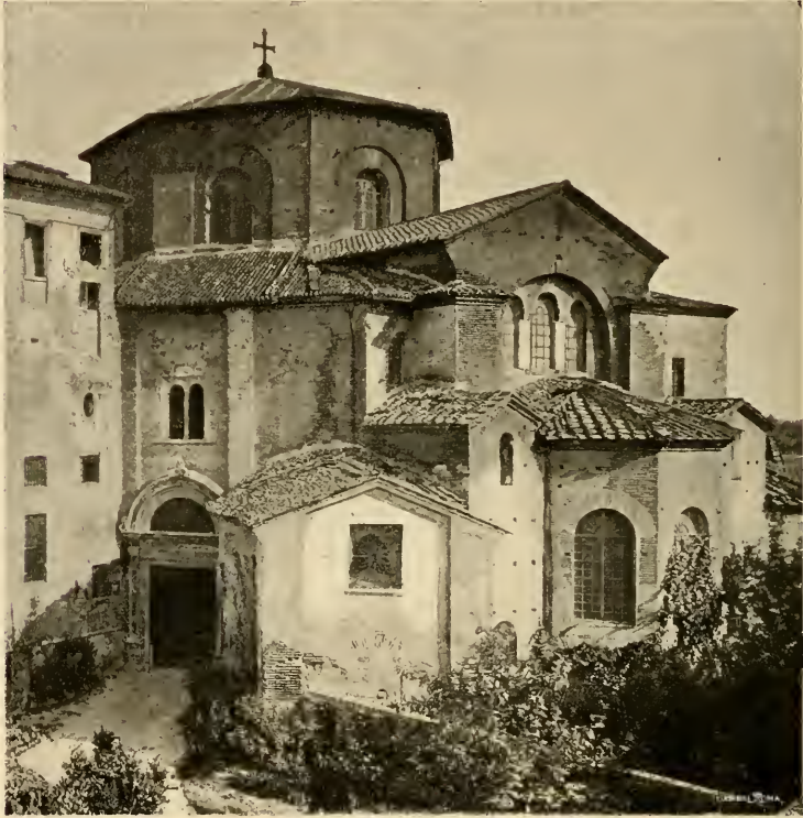
Fig. 87 — Veduta esterna della basilica di San Vitale a Ravenna, avanti i restauri in corso (a. 1826-547)
